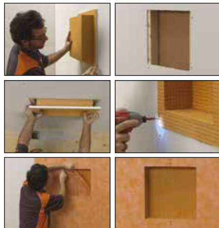
Mise en œuvre sur plaques de plâtre
