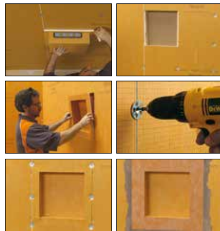
Mise en œuvre sur KERDI-BOARD
